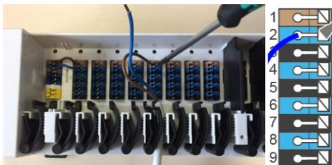
Massive Leitungen oder Kabel mit speziellen Aderendhülsen können einfach in die Klemmen eingedrückt werden.
